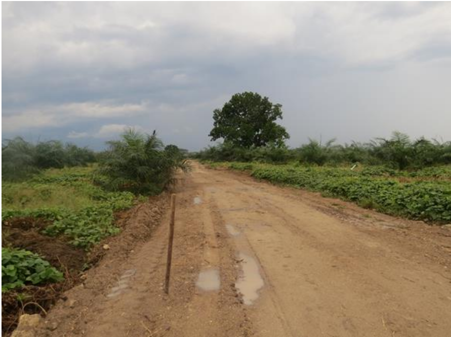
Figura 2. Mantenimiento de vías ante incremento de lluvias.
